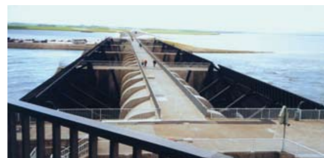
Hamburg – Sperrwerk Eidermündung
