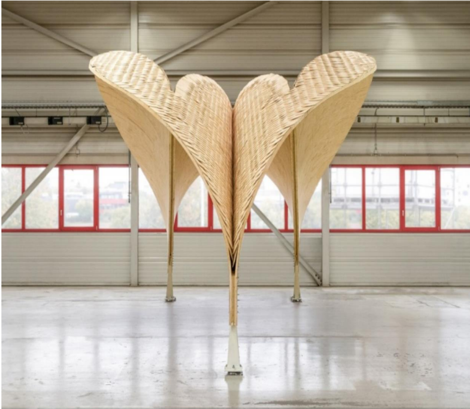
Die Struktur von HygroShell besteht aus einer 10 m langen Hauptspannweite aus sich verschneidenden bogenförmigen Gewölben, die auf drei gelenkigen Stützen ruhen. © ITECH/ICD/ITKE University of Stuttgart
